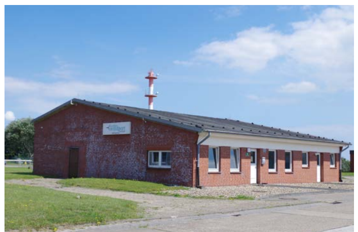
Abb. 29 Nordsee windport Borkum im Ortsteil Reede
