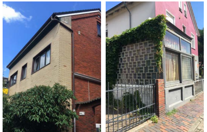
Abb. 47 Überformte Fassaden und (energetischer) Sanierungsbedarf
