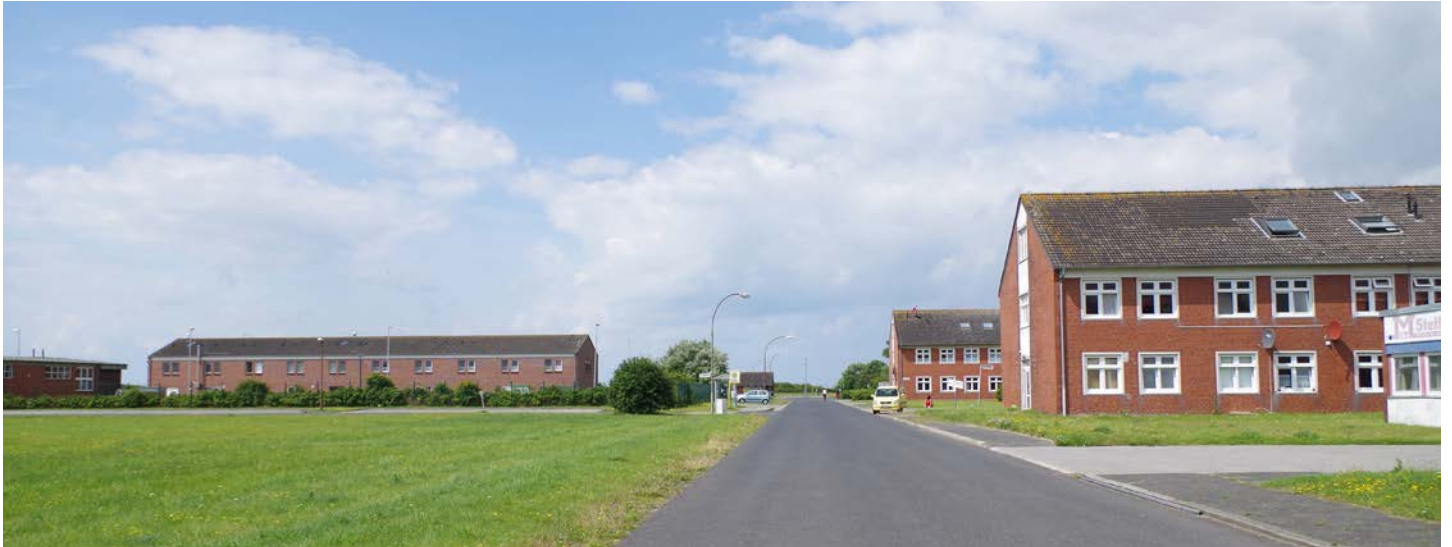
Abb. 66 Nachgenutzte Kasernengebäude entlang der Juister Strate mit großen Brachflächen
