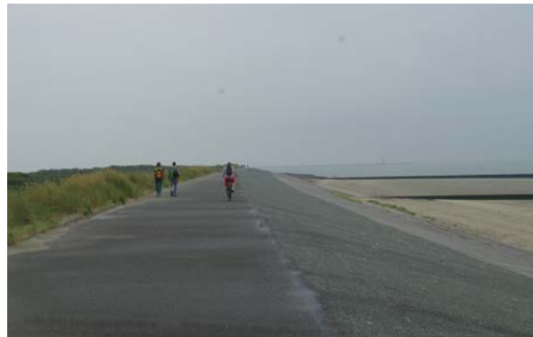
Abb. 60 Betondeich am Südstrand
