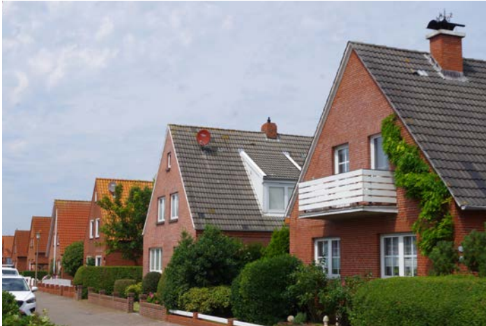
Abb. 53 Ortstypische Giebelständige Bebauung mit rotem Klinker
