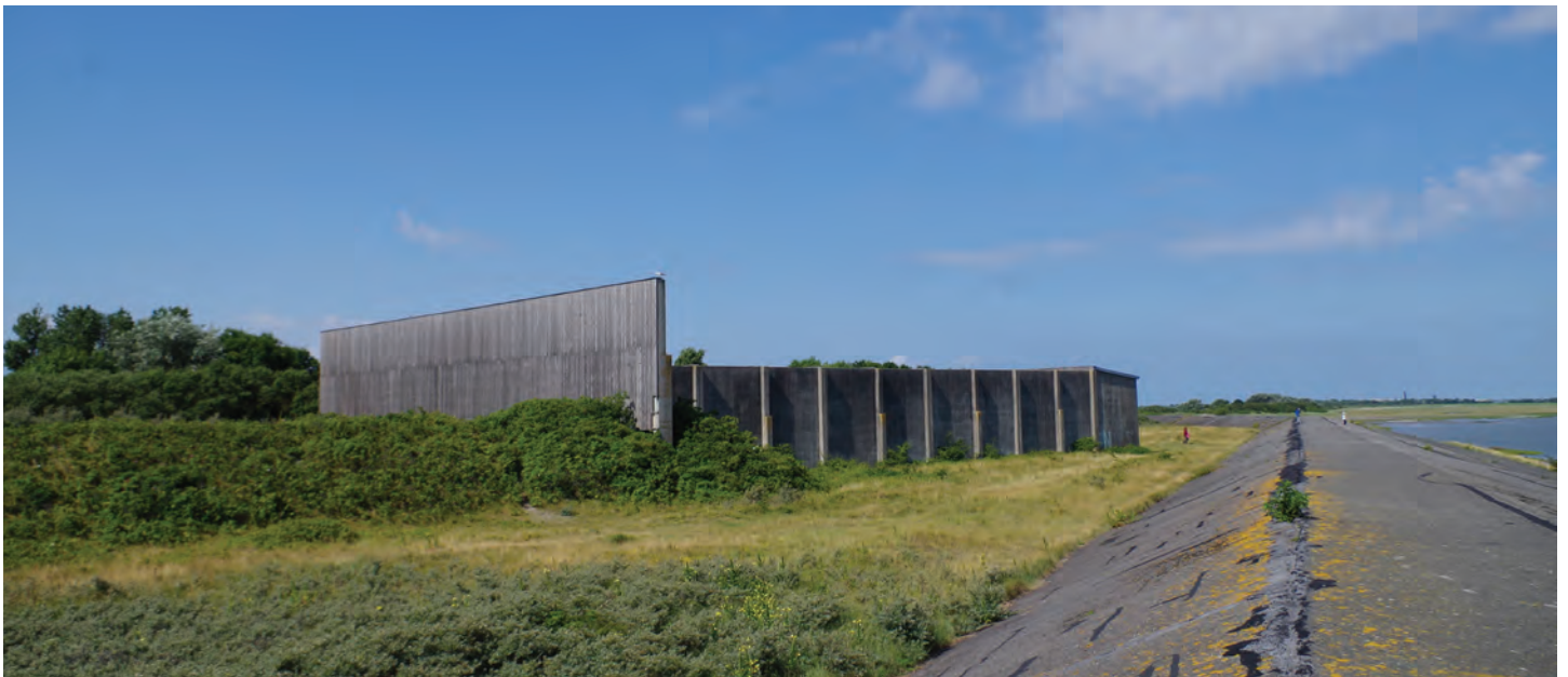
Abb. 29 Teerdeich und Schießanlage nördlich der Jugendherberge, die Flächen ist aktuell Bestandteil einer Biotopkartierung
