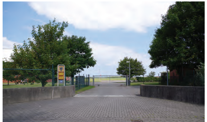
Abb. 34 Hochwasserschutzmauer mit Deichscharte an der Reedestraße
