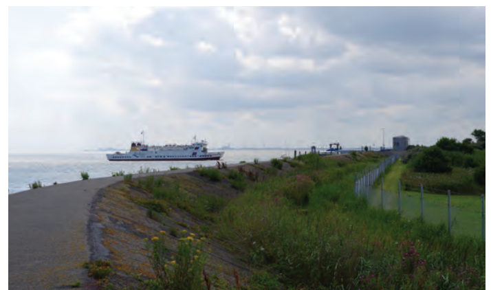
Abb. 35 Deich mit Sanierungsbedarf sorgt für Gebietsschutz
