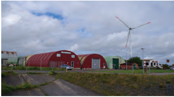
Abb. 37 Tonnendächer am Südpier
