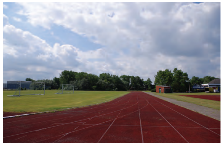
Abb. 32 Sanierungsbedürftige Sportanlage aus Bundeswehrzeiten
