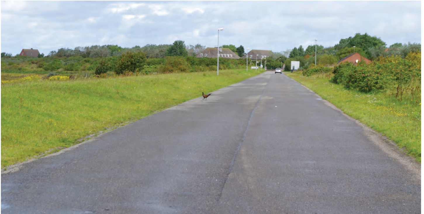
Abb. 23 Fehlende Straßenmarkierung sowie fehlende Geh- und Radwege entlang Am Neuen Hafen
