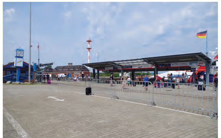
Abb. 25 Funktionale Gestaltung des Hafenbahnhofs mit mangelhaftem Witterungsschutz
