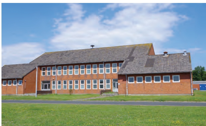
Abb. 20 Leerstand und hoher Sanierungsbedarf an der Westkaje
