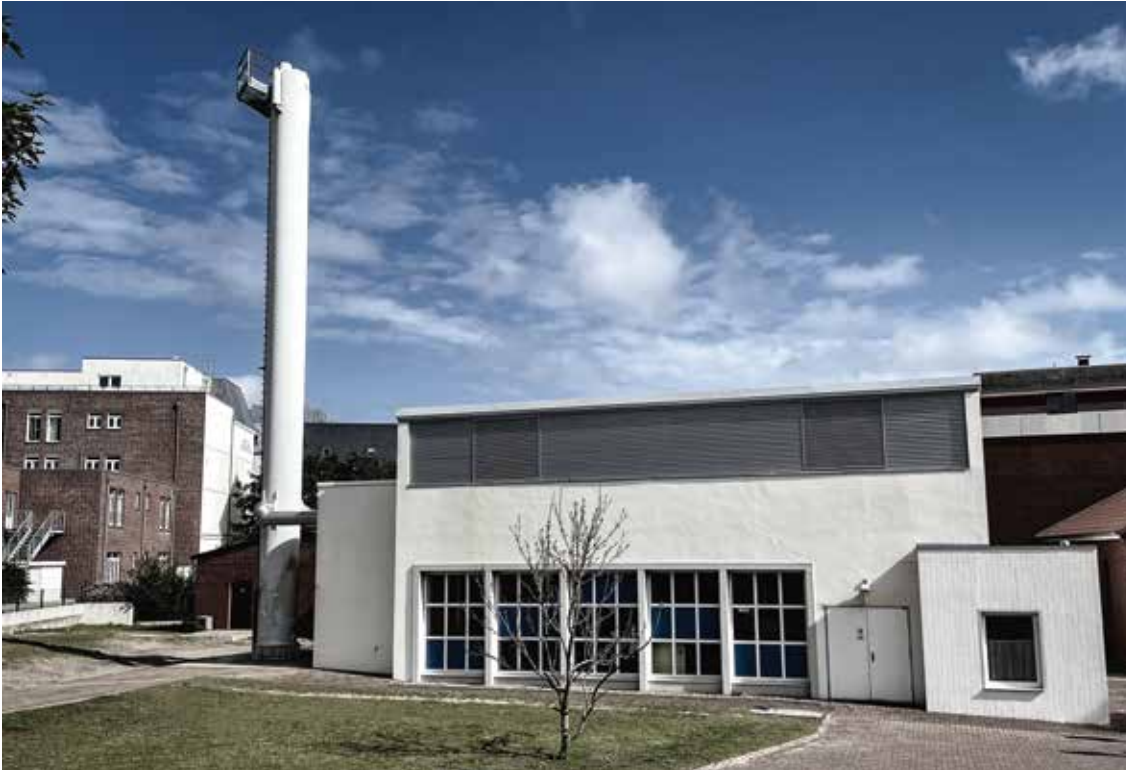
Das frisch sanierte BHKW in der Bubertstraße
